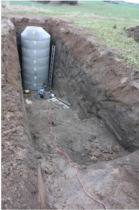
Abbildung 8: Bau der Schächte
